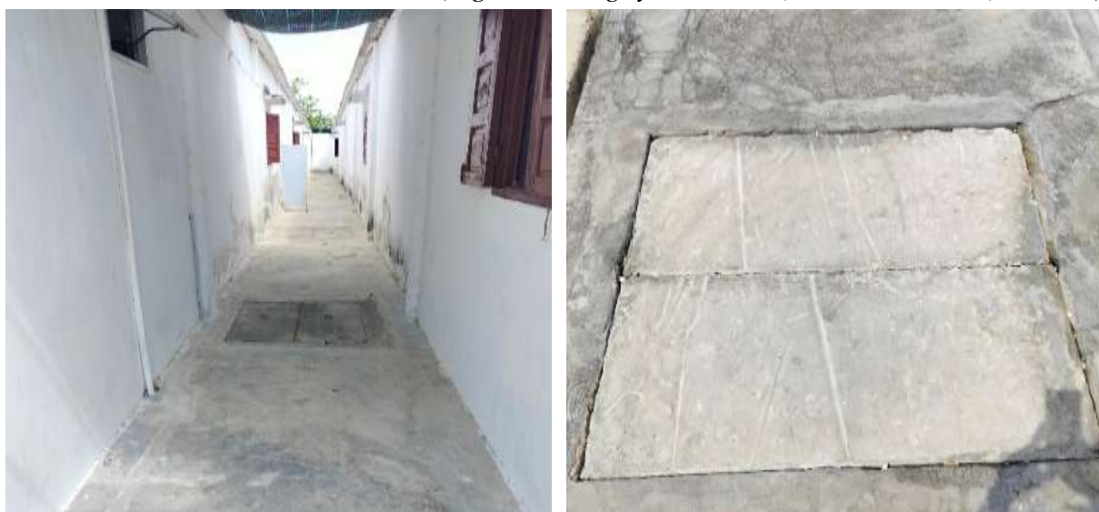
Hình 3. Hố ga thu gom nước thải
